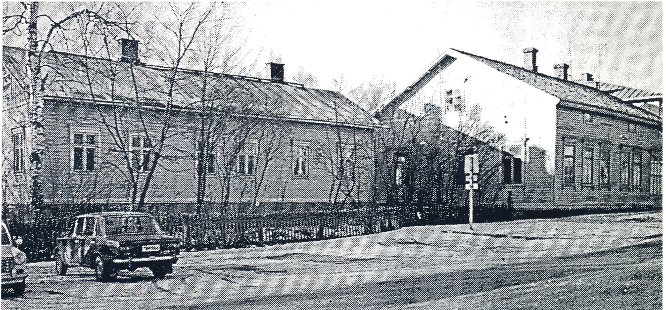
Parantajien talot, Marttilank. 23 (kortteli 14, tontti 3). Oikealla 1887 valmistunut päärakennus ja vasemmalla 1878 valmistunut "toinen talo". Rakennukset purettu 1974.
