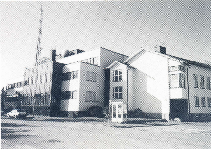
Etelä-Satakunnan Puhelin Oy:n toimitalo kesällä 1993. Vuonna 1955 käyttöön otetun toimitalon kulma ja pääsisäänkäynti näkyvät oikeassa laidassa. Toimitalon uusi osa on kuvan vasemmassa laidassa. Tämän osan katolle on pystytetty KTV-toiminnassa tarvittavaa laitteistoa. — Valokuva PK 1993.
