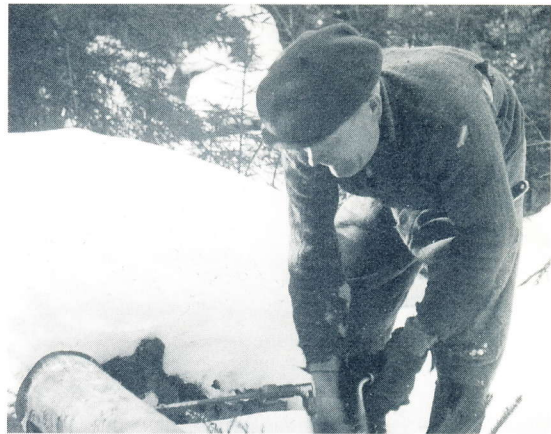
Tyrvään viimeisiä kyliä sähköistettiin joskus 1960 luvulla jolloin Ekojärvi ja Kivijärvin sai sähkövalot. Evert Mattila tekee reikää pylväseen eristäjäkoukkua varten.
