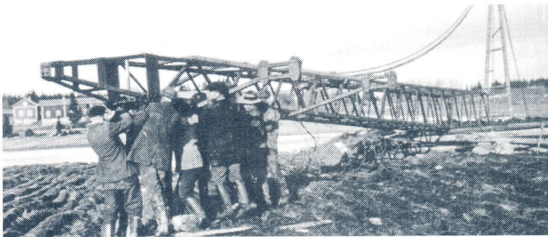
Pylväiden nostossa käytettiin sekä vinssejä että miesvoimaa.
