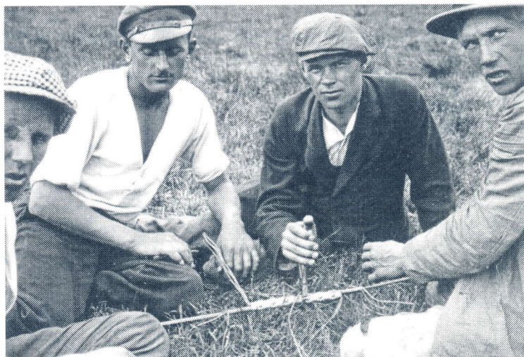
Johtojen yhdistäminen vaati huolellisuutta ja ammattitaitoa.
