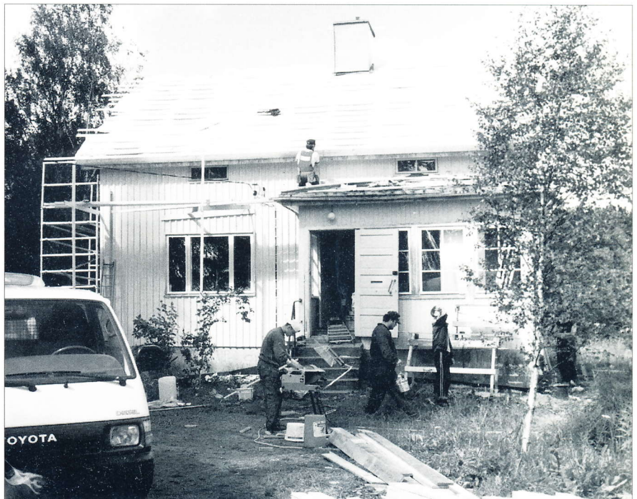
Talo sai uuden vesikatton ja komistui huomasti.
