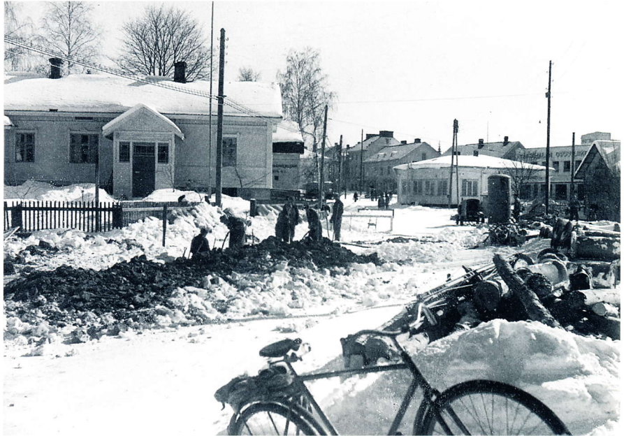
Vesijohto- ja viemäritöitä Marttilankadulla kevättalvella 1952.
