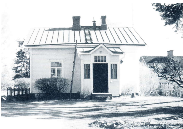
Aron talo piban ja entisen kaupan sisäänkäynnin puolelta. Kuva: Mika Sillanpää.
