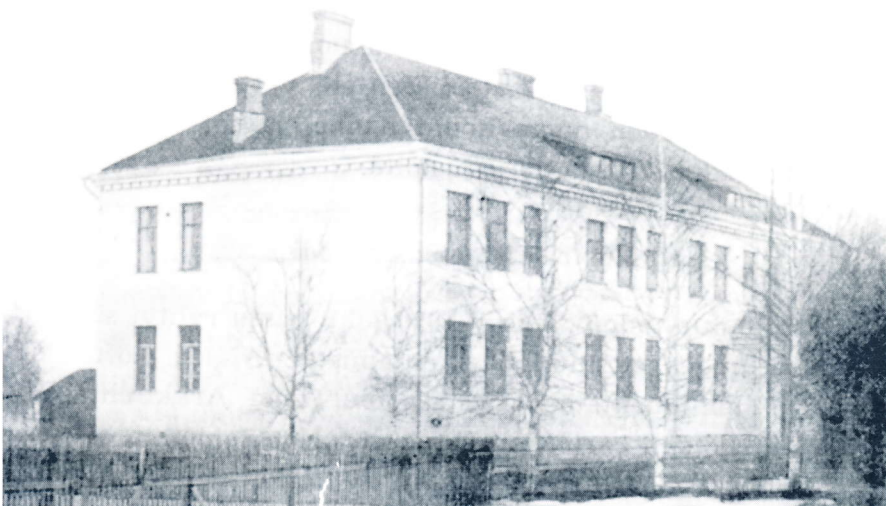
Tyrvään yhteiskoulu 1923. Näkyvässä oleva pääty ennen siihentehtyä lisärakennusta.)
