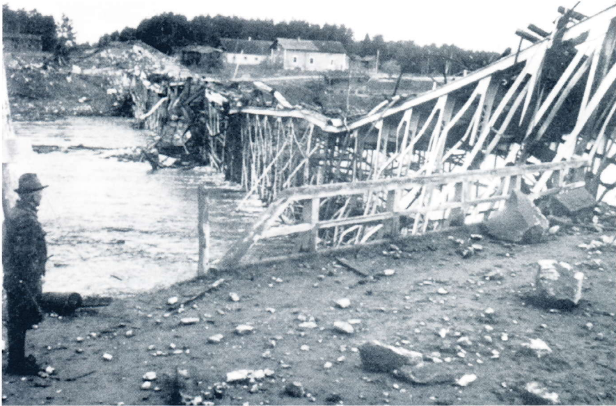
Saksalaiset räjäyttivät Iijoen sillan kabtena osana, jotta läbeiset rakennukset eivät olisi vaurioituneet. Näin vielä tässä vaiheessa. Saksalaiset halusivat itse määrätä vetäytymisensä aikataulun. Eniten he pelkäsivät puna-armeijan suurhyökkäystä. Poliittisesti Lapin sota oli Suomelle välttämättömyys. – Kuva Sampo Ahdon teoksesta "Aseveljet vastakkain".
