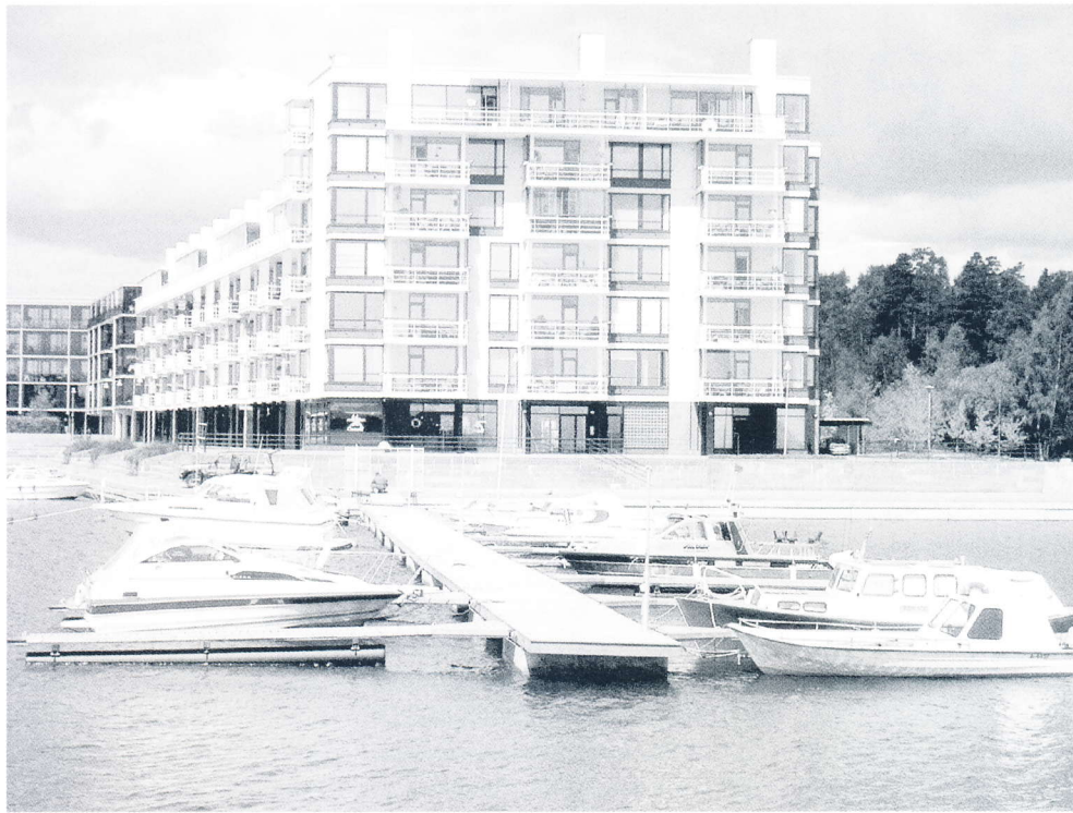
Yrityksen päätuote on laituri. Tässä kuvassa Laakson rakentama pienvenesatama Helsingissä.
