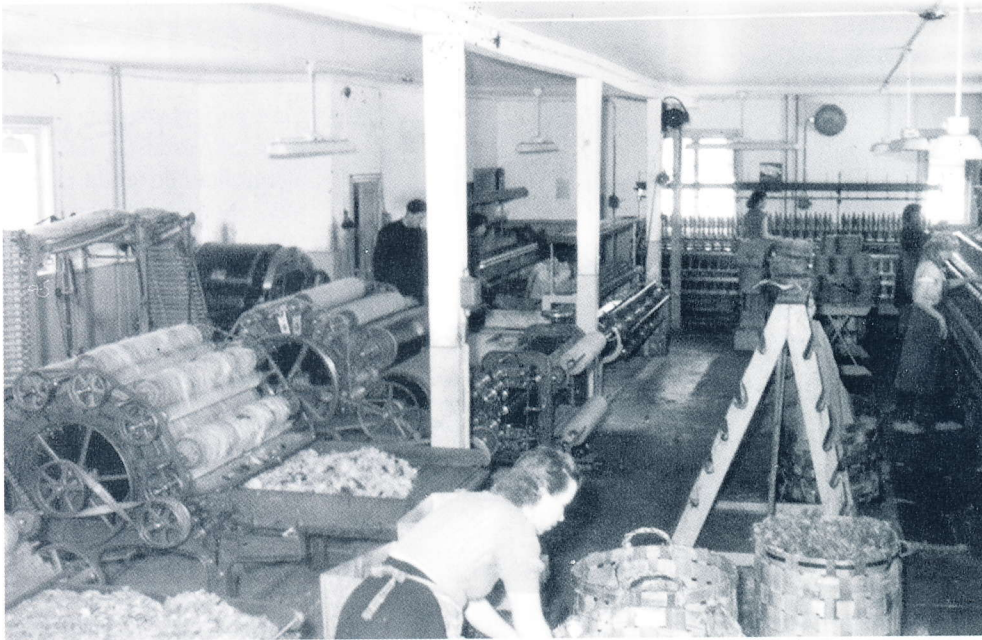
Karstakoneita Tyrvään Villa Oy:n uudessa tehdasrakennuksessa 1950-luvulla. Ensimmäisen kerroksen yhtenäisen kehuusalin keskellä kantava pilari- ja palkkilinja. Toisessa kerroksessa oli toimisto ja muita tiloja.
