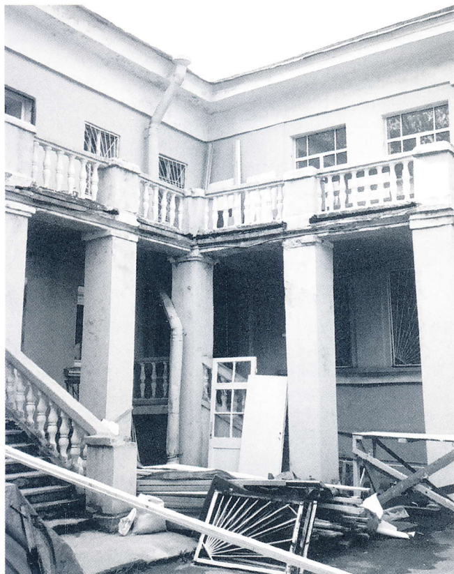
Sisäpihaa korjaustyön aikana.
