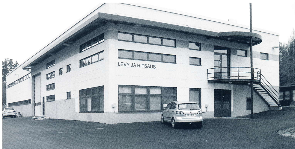
Uusi levy- ja hitsaushalli valmistui Vammalan ammattikoulun alueelle tänä syksynä.
